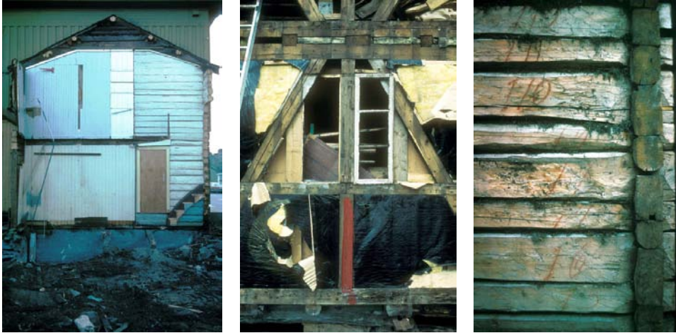
Mosjön f.v., ett avtryck av ett hus; Sjögata 23e; prefabrikerat hustimring. Foto. Dag Nilsen. NTNU.
