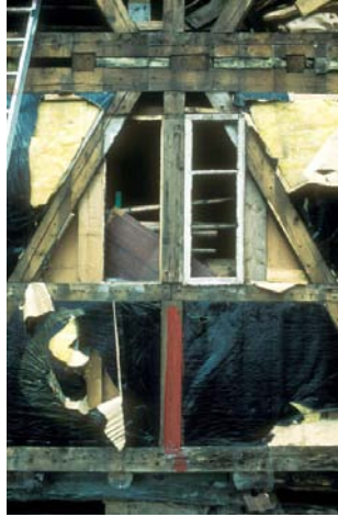
Mosjøen f.v., et avtryk av et hus; Sjøgata 23e; prefabrikkert hustømring. Foto. Dag Nilsen. NTNU.
