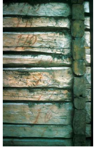
Mosjøen f.v., et avtryk av et hus; Sjøgata 23e; prefabrikkert hustømring. Foto. Dag Nilsen. NTNU.
