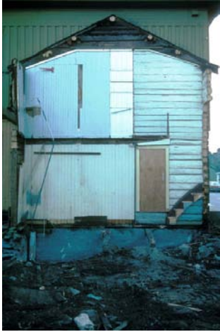
Mosjøen f.v., et avtryk av et hus; Sjøgata 23e; prefabrikkert hustømring. Foto. Dag Nilsen. NTNU.
